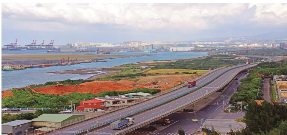
圖四 台 61 線快速道路
